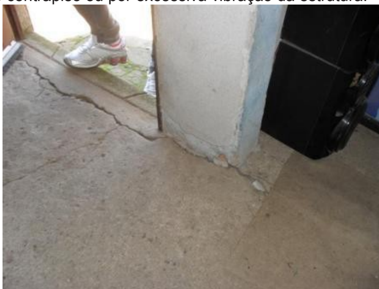
Figura 8: Movimentação do contrapiso.
